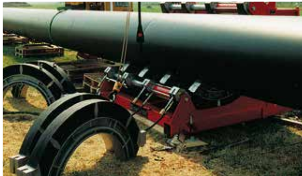
PE pipe run DN 800
