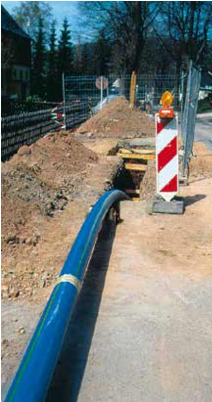
Insertion pit PE relining DN 300
