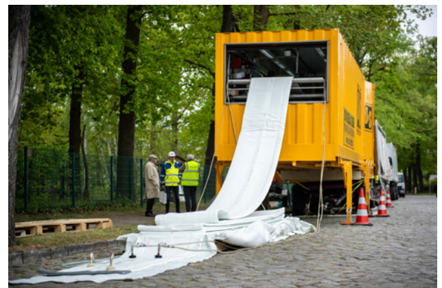
Bild 2: Mobile Tränkfabrik für die Liner-Imprägnierung
