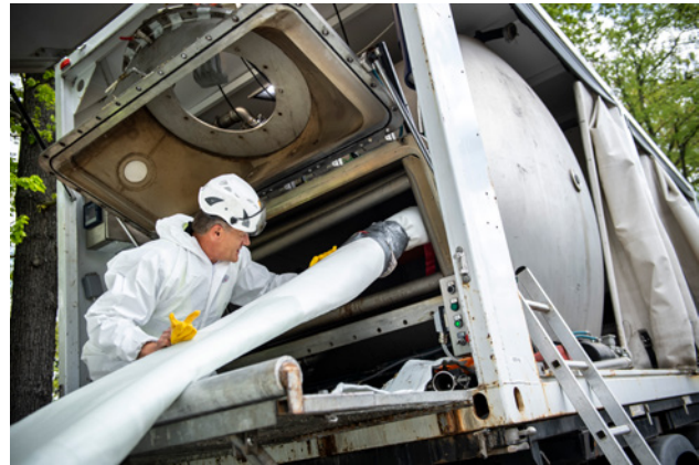
Bild 4: Einführen des getränkten Liners in die Inversionstrommel
