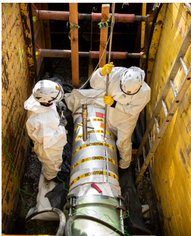
Bild 6: Montage des Dampfauflassventils in der Zielbaugrube
