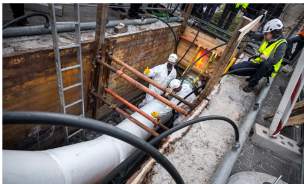
Bild 5: Inversion des Liners in das Altrohr
