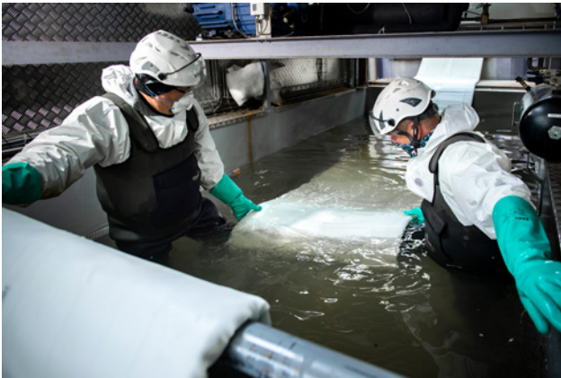
Bild 3: Zwischenlagerung des mit Epoxidharz getränkten Liners im kalt temperierten Wasserbad, um die Reaktionszeit des Harzes zu verlängern
