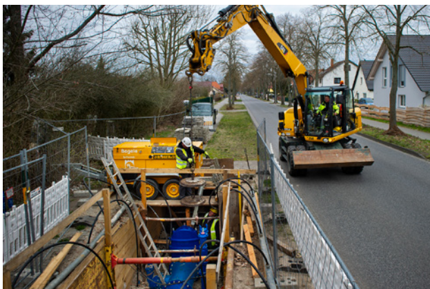
Bild 1: Von der D&S Bauunternehmung NL Dessau errichtete Startgrube mit neuen Armaturen
