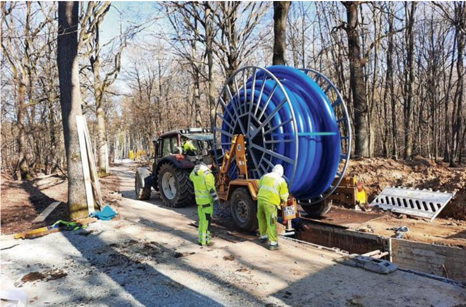
Installation einer vorverformten PE-Rohrleitung Compact Pipe, DN 400, SDR 17, PE 100, passgenau in eine vorhandene Altrohrleitung vom Hochbehälter Braumanns bis zum oberen Reisberg.
